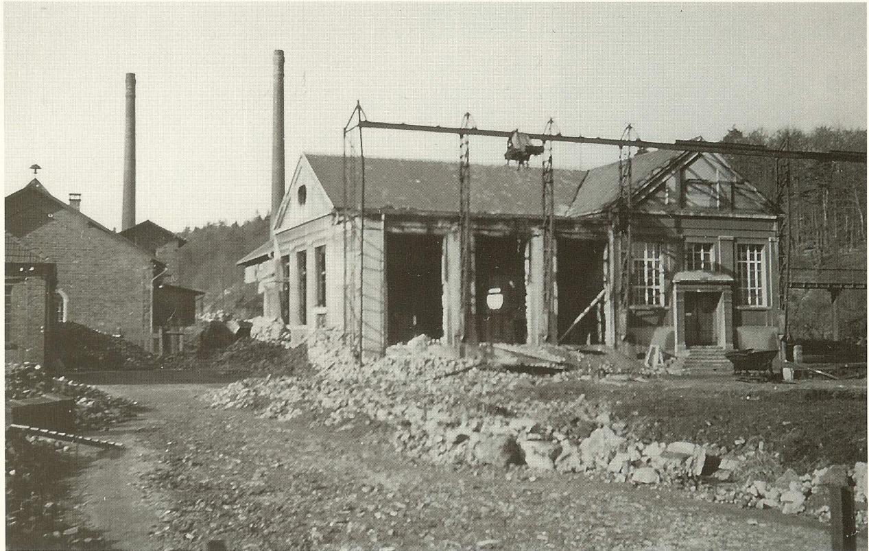
Später wurde das Transformatorenhaus in seiner Funktion nicht mehr benötigt und zur Lehrwerkstatt umgebaut. Dem Umbau fiel auch die Kranbahn zum Opfer, die man zum Transport des Brennmaterials für die Dampfmaschinen nutzte.
