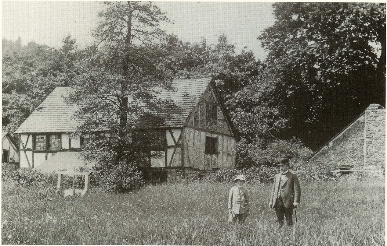
Die Schleiferei, heute noch „Schleif“ genannt, ist als Fachwerk gebaut. Sie wurde mit Wasserkraft betrieben, und man nutzte den Hüttengraben, der hier die entsprechende Schleuse aufwies und das Gefälle für den Wasserradantrieb sicherstellte.
