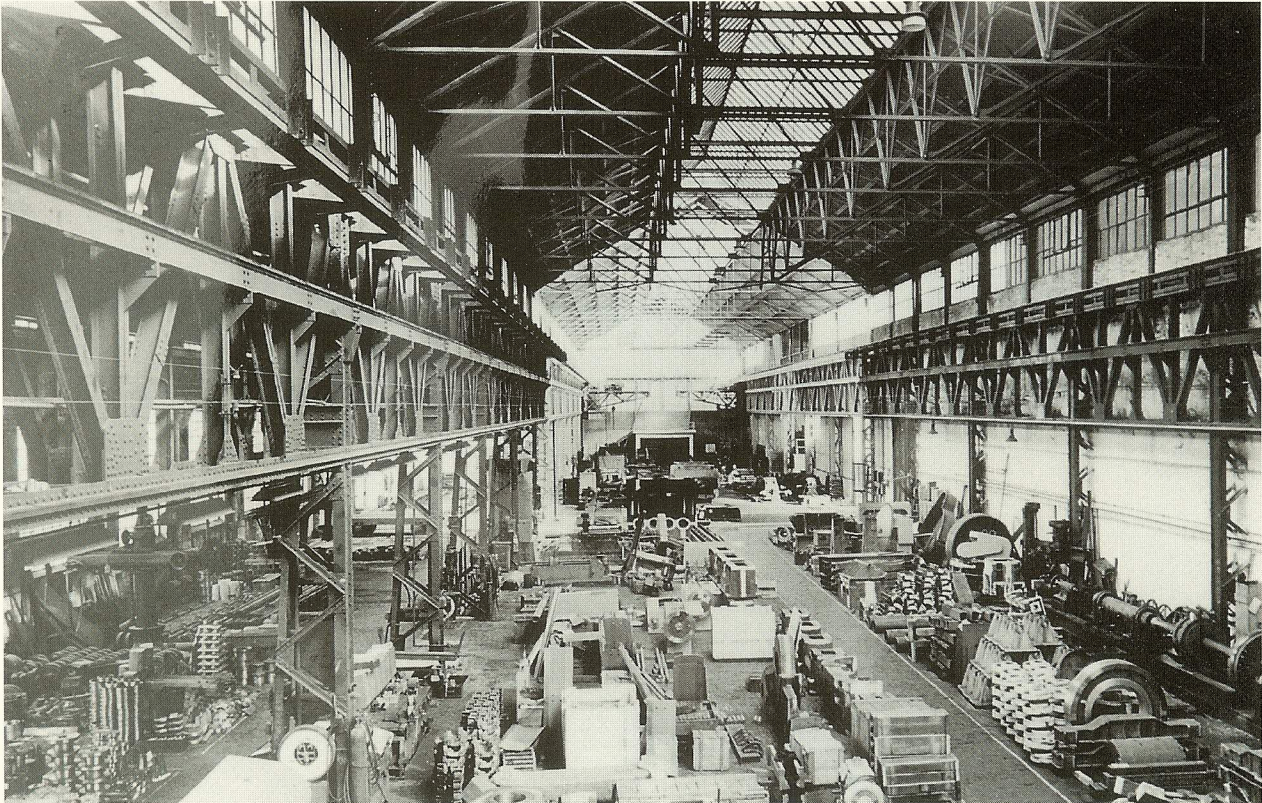
Das erweiterte Produktionsprogramm in Form von Schweißkonstruktionen, Gießereimaschinen und Hüttenfahrzeugen in der verlängerten Maschinenbauhalle.
