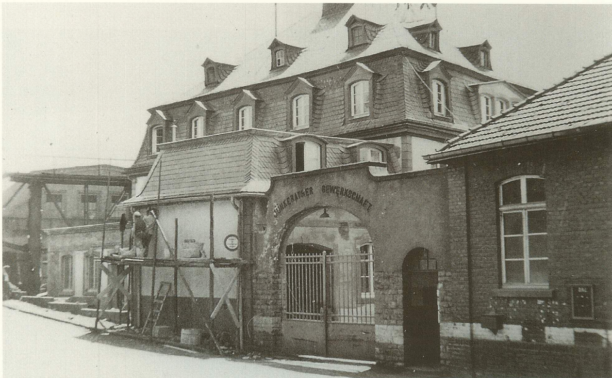
Das Verwaltungsgebäude wurde 1770 erbaut. Wegen seiner markanten Architektur und historischen Bau- substanz stellte die Kreisverwaltung es am 27. 9. 1984 unter Denkmalschutz. Die angebaute Portierloge wurde im Zuge des Neubaues des Technischen Büros 1953 abgerissen und in den entstandenen Neubau integriert.
