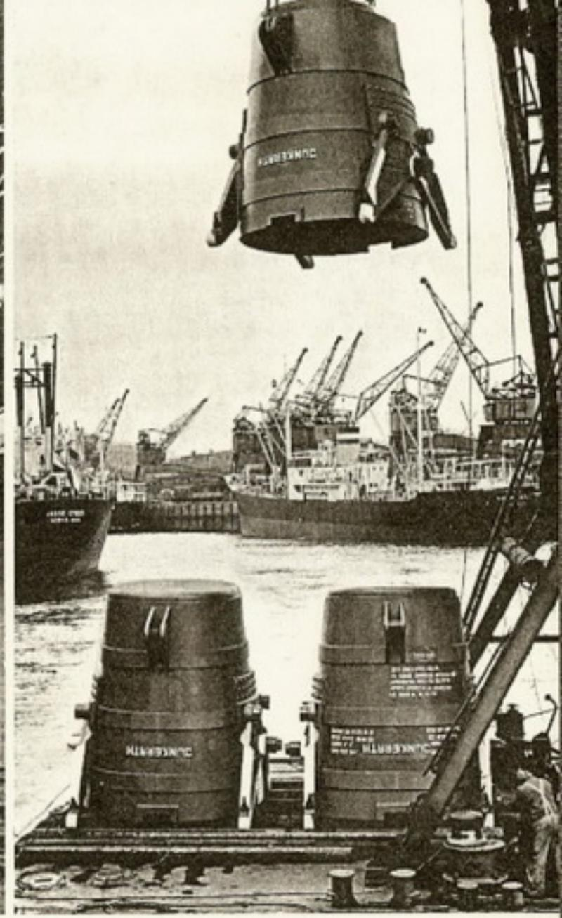
Verladung der Platten einer Serie Roheisen-Transportwagen mit Hilfe eines Schwimmkranes.
